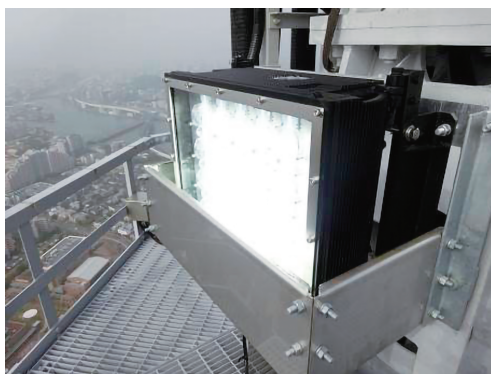
写真2 高光度航空障害灯
